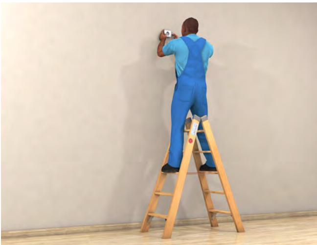
Abb. 56 Sicherer Stand auf einer beidseitig begehbaren Stufenstehtleiter
